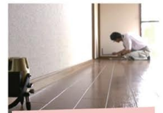
床の傾き・外壁のひび 割れなどの計測
