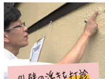
外壁の浮きを打診、 窓・ドアの開閉 状況を確認
