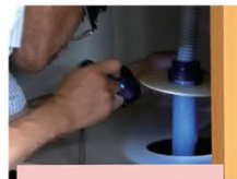
設備の錆や配管の 水漏れを作動確認
